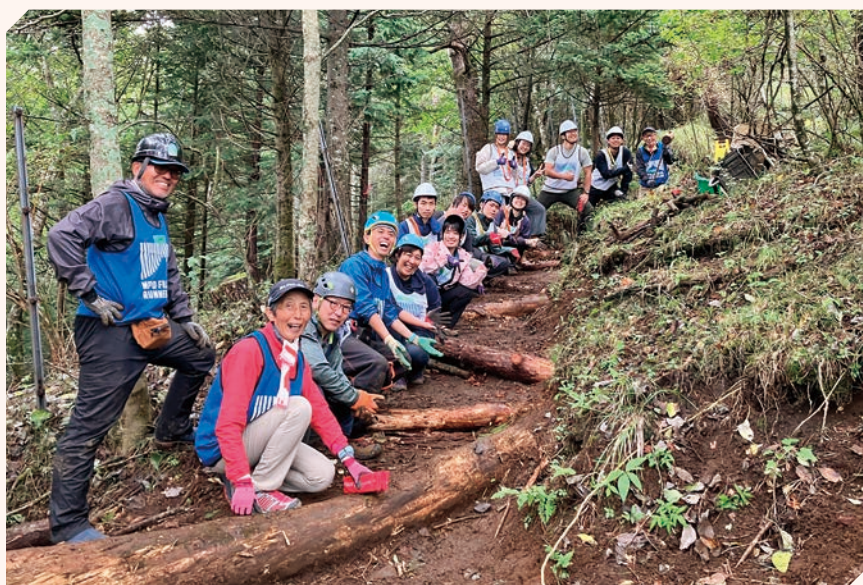
みんなでつくった登山道。これで完成ではなく、道の状態や植生の回復状況などを継続的にモニタリングしていきます
